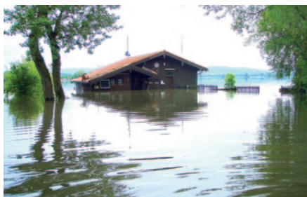
Oft schon stand die Hütte der Wasserwacht unter Wasser. Das letzte Hochwasser 2013 zerstörte fast die gesamte Einrichtung
