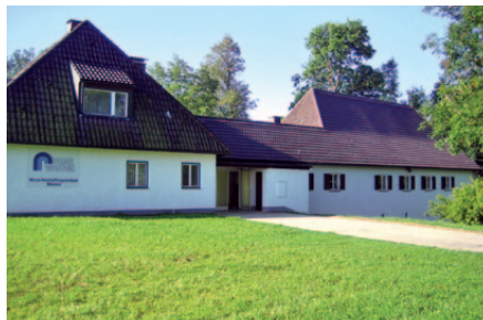
In Aumühle steht die Betriebsstätte des Wasserbeschaffungsverbandes
