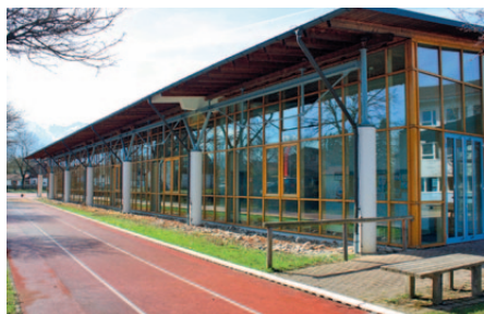
1967 entstand an der Grassauer Straße die erste Turnhalle, die 1994 durch die heutige ersetzt wurde
