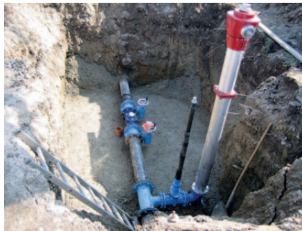
Ein Wasserzähler wird in die Wasserleitung eingebaut (hier nördlich der Bahnunterführung Moosen), dessen Daten an das Wasserwerk gesendet werden
