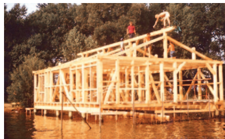
Auf Pfählen im Wasser entstand die erste Station der Wasserwacht am Überseeer Strand. 1979 gab es nach langem Ringen endlich die Genehmigung
